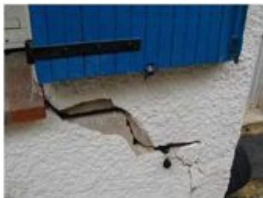
La commune peut être affectée par le phénomène de retrait-gonflement des argiles entraînant des mouvements de terrains. En effet, sous l'effet de la sécheresse, certaines argiles (ici les argiles d'Orchies, e3) se rétractent de manière importante et entraînent localement des mouvements de terrain non uniformes pouvant aller jusqu'à provoquer la fissuration de certains pavillons.
